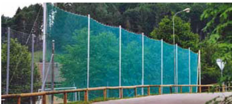
Bei den Pfostenabständen empfehlen wir eine Distanz von ca. 5 m einzuplanen. Für ein Höchstmaß an Stabilität empfehlen wir jeweils am Ende des Ballfangzaunes den Einsatz von Schrägstützen oder Quertraversen! **Gerne helfen wir Ihnen bei der Planung Ihres Ballfangsystemes. Sprechen Sie uns an!**
